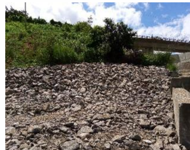
Proteção com enrocamento
