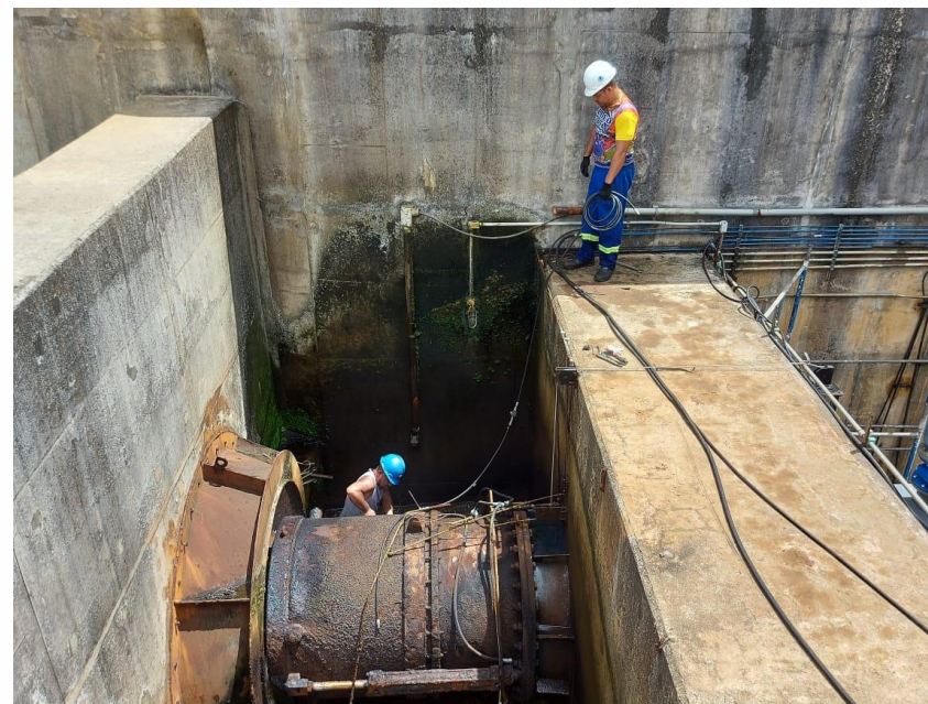
Correção das válvulas dispersoras e borboletas. Fonte: SERH
