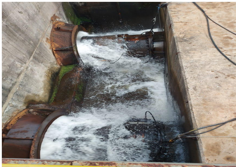
Correção das válvulas dispersoras e borboletas. Fonte: SERH
