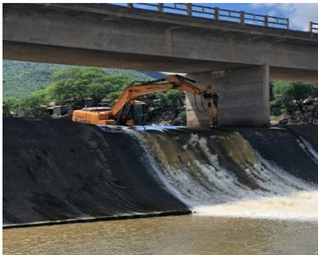
Demolição parcial da ogiva do vertedouro.
