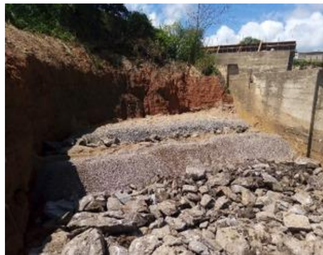
Execução de filtro invertido
