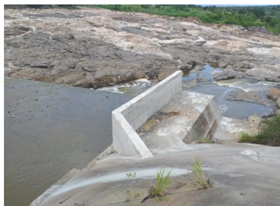
Elevação do muro lateral
