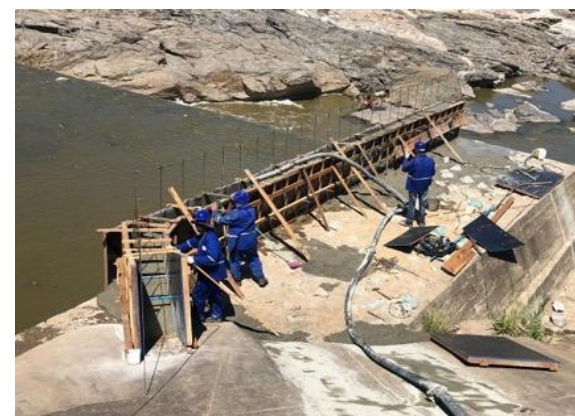
Concretagem do muro lateral
